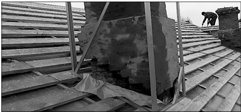
В 2018 году внимание сосредоточат на ремонте крыш и инженерных коммуникаций.
